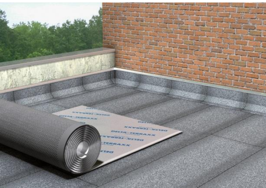
Fig. 24c – déroulement des nappes sur le support
