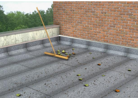
Fig. 24a – préparation du support
