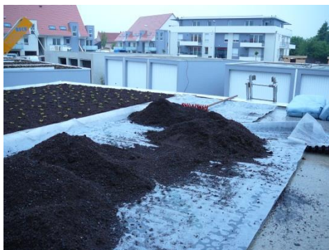
Fig. 24l – exemple de pose DELTA®-FLORAXX TOP (source : Doerken)
