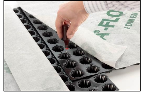
Figure 18b – recouvrements transversaux (abuts de lés) de la nappe DELTA®-FLORAXX TOP
