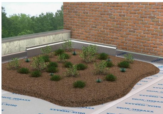
Fig. 24i – mise en place du substrat
