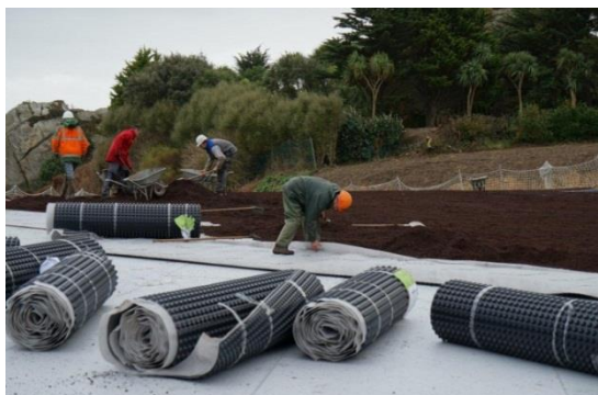
Fig. 24k – exemple de pose DELTA®-FLORAXX TOP (source : Doerken)
