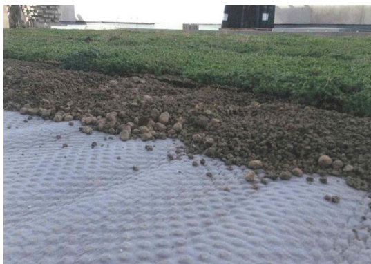
Fig. 24j – exemple d'application de la nappe DELTA®-NP DRAIN (source : Séquoia)
