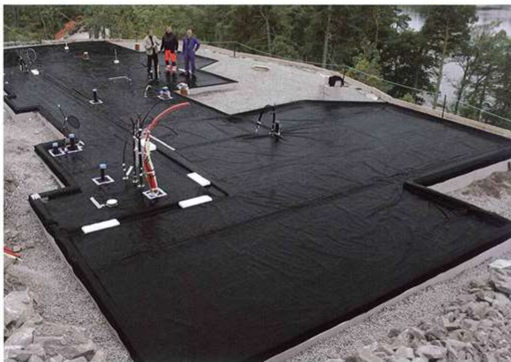
DELTA®-RADONSPERRE – bariera zapewniająca ochronę przed działaniem radioaktywnego radonu z gleby.
