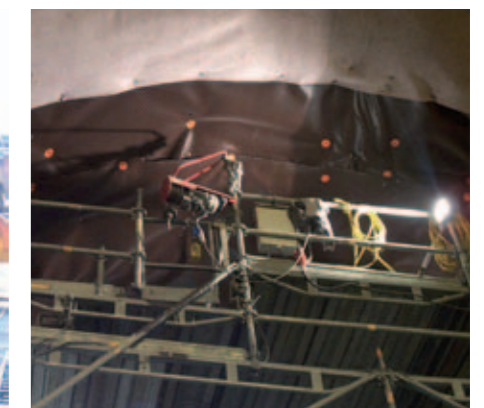
DELTA®-MS wird verlegt.
