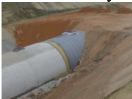
Przykłady z terenu: tunel kolejowy Kemalpaşa zbudowany metodą odkrywkową cut-and-cover w pobliżu Izmiru, Turcja
