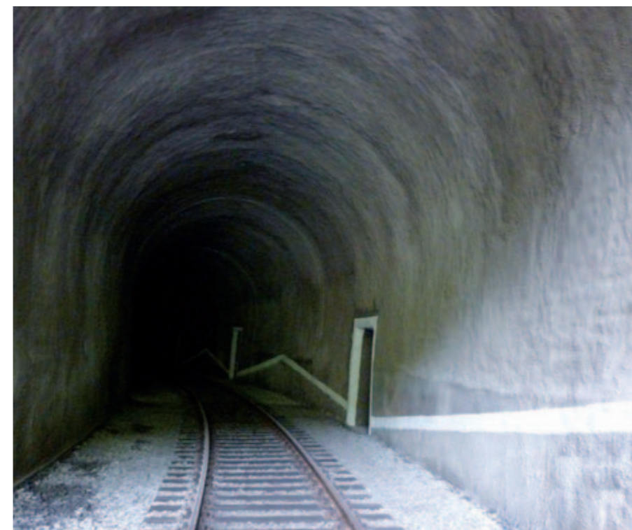
Nowa wewnętrzna osłona ze zbrojonego betonu natryskowego.
