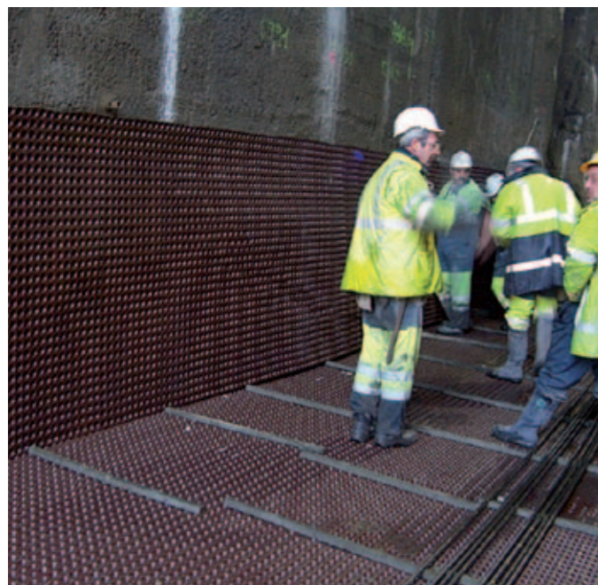
Folie ułożone podwójnie wzdłuż węzłów.
