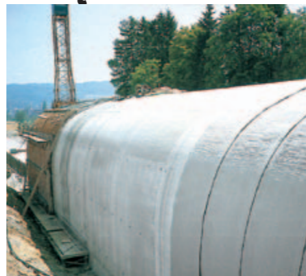
Przykłady z terenu: tunel Föhrlibuck W szwajcarskim tunelu Föhrlibuck o długości 200 m, który łączy wiadukty Neugut i Weidenholz w Wallisellen, zużyto ponad 6 000 m 2 folii drenażowych DELTA®. Dzięki ich wysokiej wytrzymałości na ściskanie, tunel można było pokryć warstwą 150 000 t sypkiej skały o grubości od 2,0 do 3,5 m.
