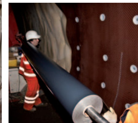
Nakładanie warstw izolacji wodochronnej.
