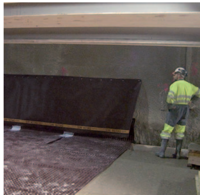
DELTA®-MS 20 na dnie, DELTA®-MS na ścianie.
