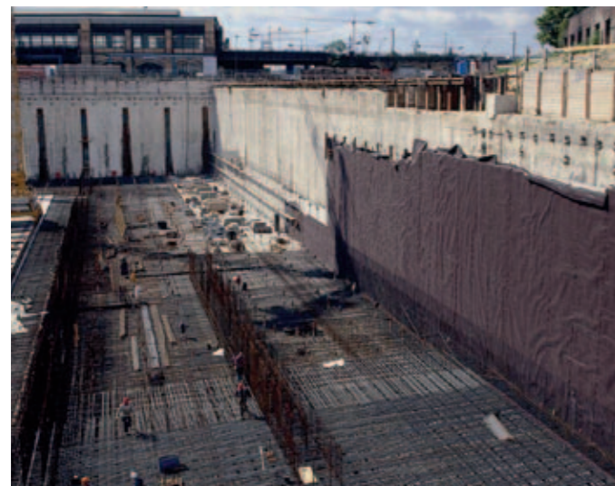
16 Przykład: zastosowanie ściany szczelinowej w Duisburgu.
