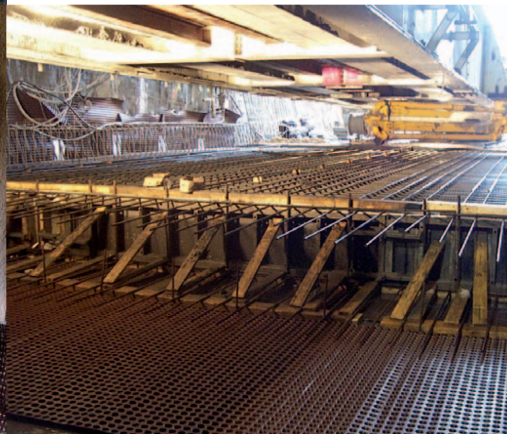
DELTA®-MS 20 zur Sicherung der Tunnelsohle.
