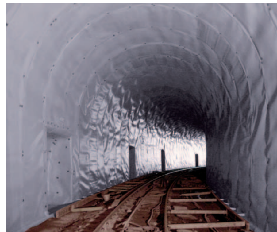
Kompletny tunel kolejowy z użyciem obudowy DELTA®-PT.
