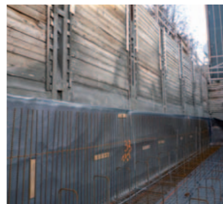
Obudowa „berlińska”: Budynek Volkswohlbund w Dortmundzie.
