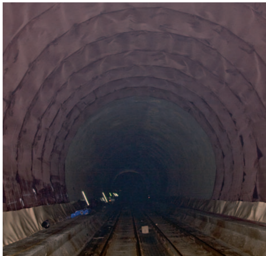
Widok tunelu Gottharda z zainstalowaną folią DELTA®-AT 1200.
