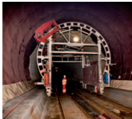
Mocowanie folii bezpośrednio z wózka instalacyjnego.
