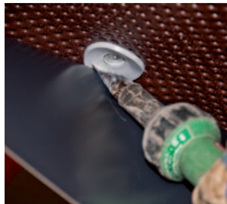
Zgrzewanie warstw izolacji wodochronnej do podkładek.
