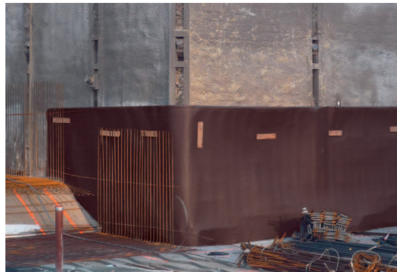
Obudowa typu 'Essen' przy użyciu DELTA®-MS.
