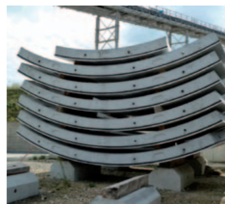
Siedem tubingów formuje jeden pierścień.
