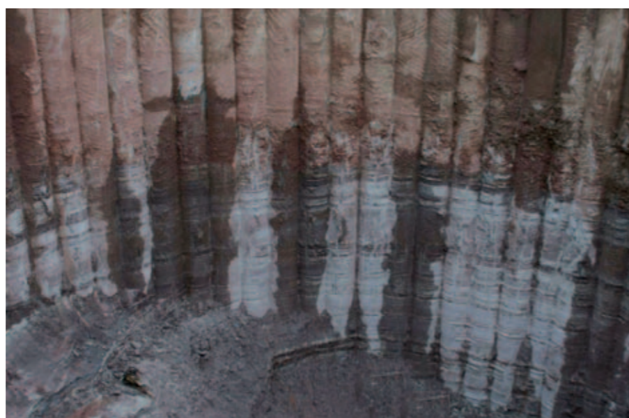
Ściana z pali wierconych przed zastosowaniem warstwy drenażu.
