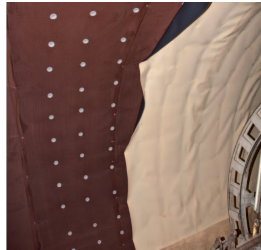
Dodatkowe mocowanie za pomocą podkładek, do których później zgrzewana będzie izolacja wodochronna.
