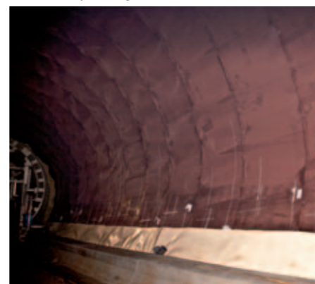
Początkowo folie są mocowane tylko w pokrywających się strefach.
