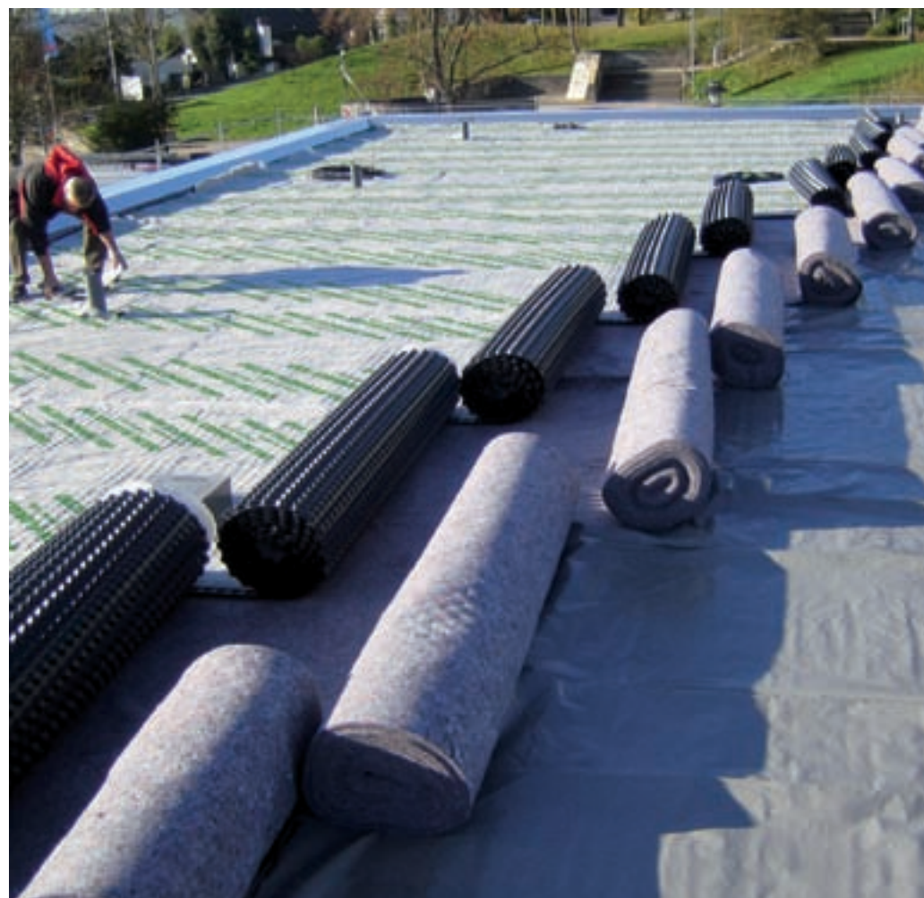
Zintegrowana geowłóknina pozwala oszczędzać czas podczas układania.
