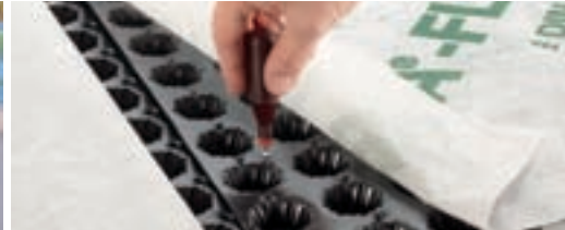
Łącznik DELTA®- FLORAXX służy do łączenia folii.
